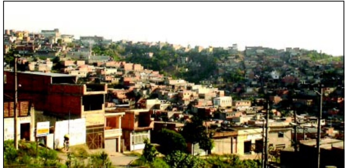
Vista parcial do bairro, repleto de carências e precariedades
